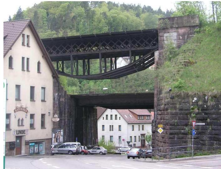
Das Ziegelbach-Viadukt (Brücke über die B296) wurde vom Statiker untersucht. Es ist für den modernen Bahnverkehr geeignet, allerdings nur eingleisig, wegen des zu engen Gleisabstandes von 3,60m.
