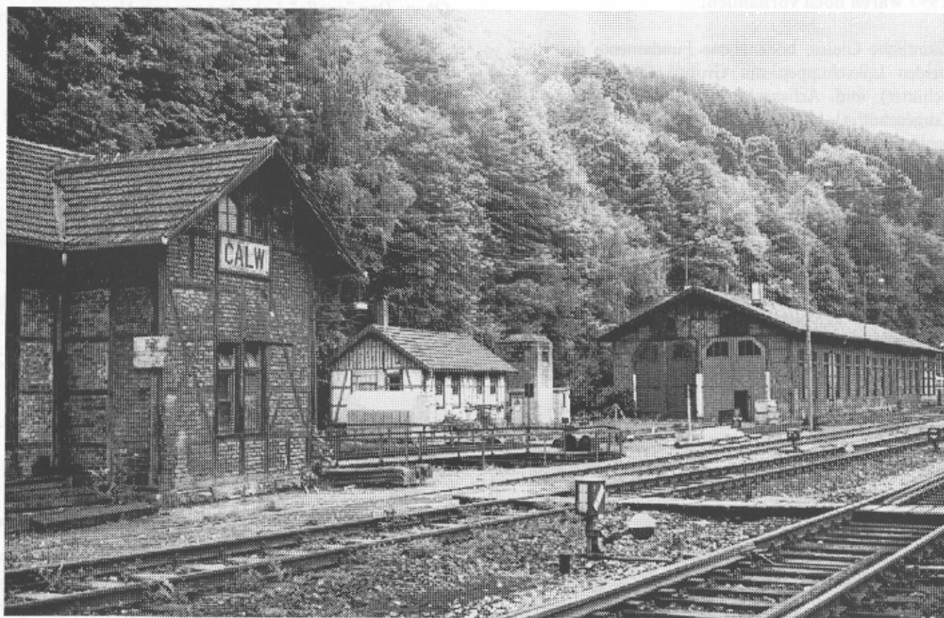
Im Bw Calw um 1972: Links der eingleisige Lokschuppen, in der Mitte die Drehscheibe, dahinter Lokleitung und Trafostation, rechts der zweigleisige Lokschuppen. Foto: Rudolf Seifferth
