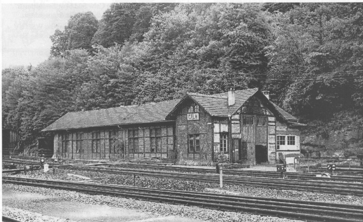
Der eingleisige Lokschuppen mit dem abgeschragten linken Ende, damit das Ziehgleis vorbeipafte. Davor die beiden (!) Gleise von und nach Althengstett, rechts die Drehscheibe. Foto: Rudolf Seiffert
