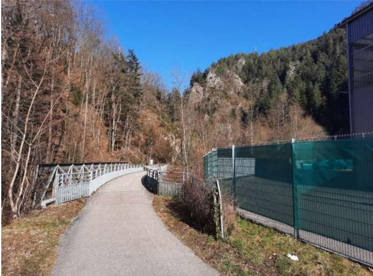
Laut Aussage des Schwarzwälder Boten vom 07.04.2016 befindet sich das eingezäunte Gelände im Eigentum der ansässigen Firma. Wenn kein Geländestreifen gekauft oder durch den Radverkehr mitbenutzt werden kann, müsste die Trasse links verbreitert werden, d.h. es würden Stützmauern auf ca. 100m Länge nötig. Um diesen Aufwand zu vermeiden, wäre eine Führung des Radwegs auf der anderen Seite der Firma zu prüfen (neben der Straße, heute Grünstreifen, siehe Google Maps)
