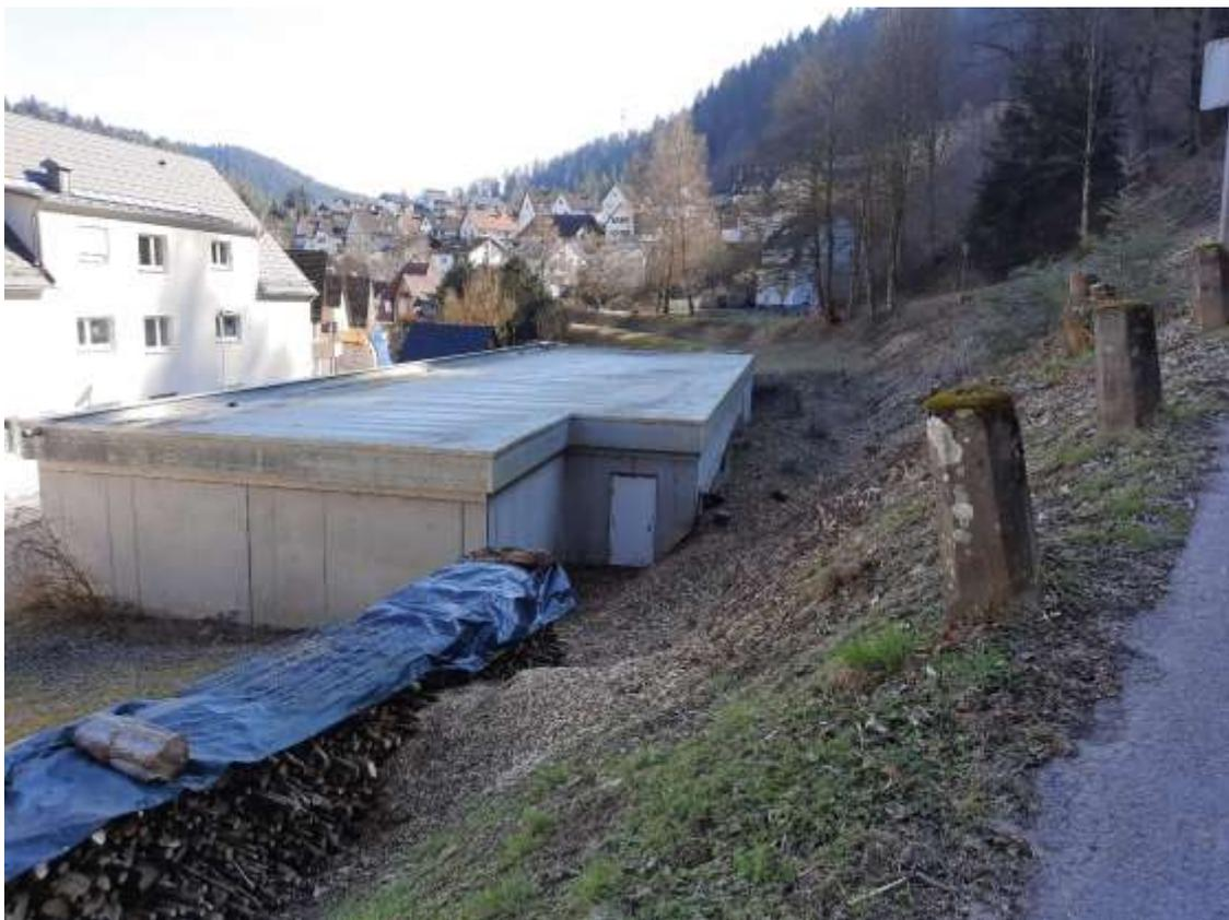
Hier müsste die Bahntrasse entweder um die Garage herumgeführt werden, was eine ca. 15m lange und bis zu 5m hohe Stützmauer erfordern würde oder die Garage müsste abgerissen und in der Nähe neu gebaut werden.
