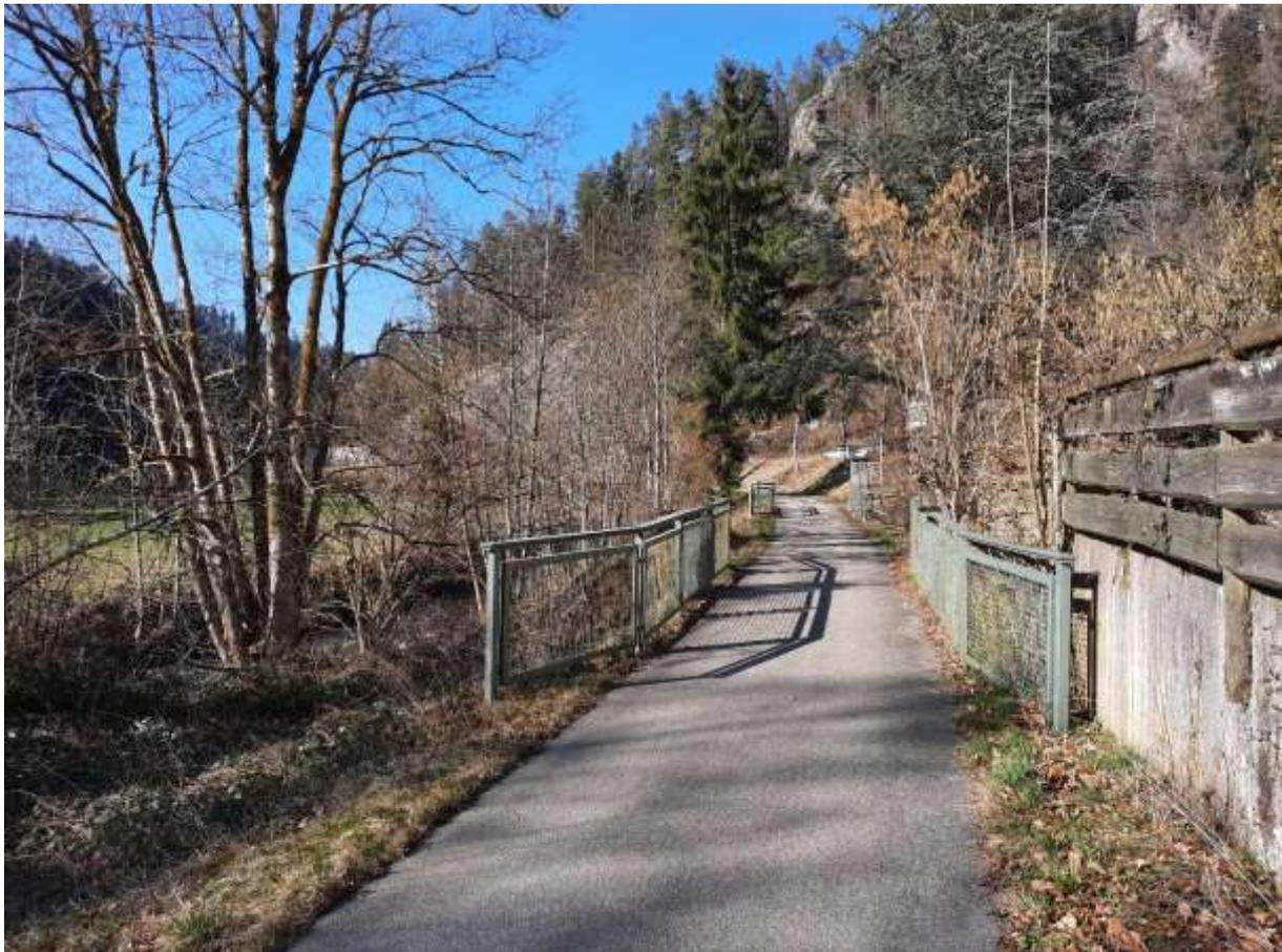
Um die Trasse zu verbreitern, sind Stützmauern auf ca. 50 m Länge nötig. Eine Alternative dazu wäre die Führung des Radweges auf der anderen Seite der Schiltach.
