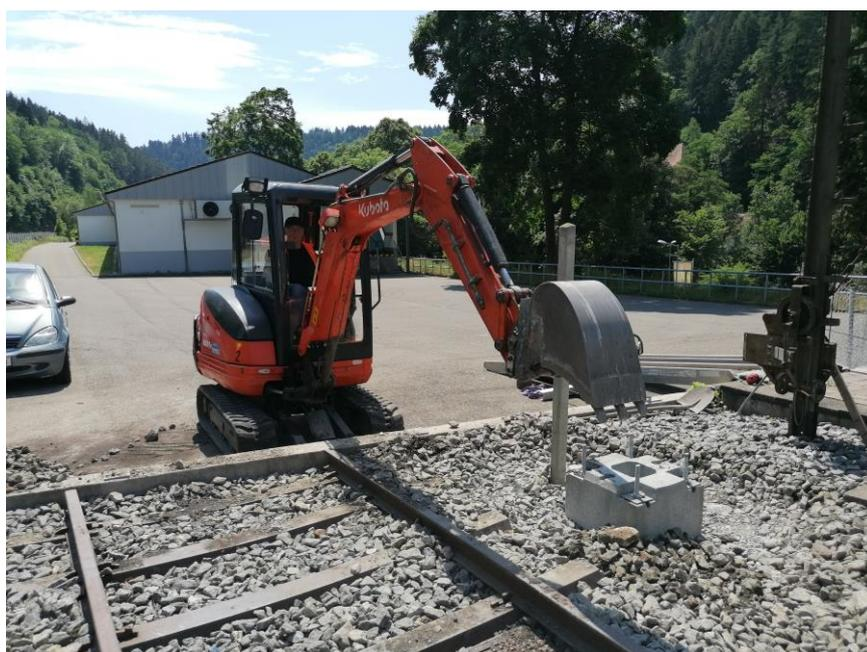
Als erstes wurde an der dafür vorgesehenen Stelle eine Grube ausgehoben. Anschließend wurden die einzelnen Segmente des Fundaments zusammengebaut. Danach haben wir schichtweiÙe Erde drum herum aufgefüllt und verdichtet und zu guter Letzt wurde oben rum noch Schotter angefüllt.
